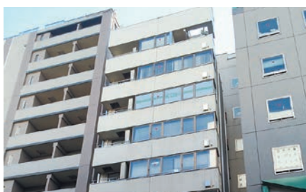
岸工業(株) 東京事務所 〒170-0013 東京都豊島区東池袋4-26-13 東栄ビル7F TEL : 03-5911-2350 FAX : 03-5911-2352
